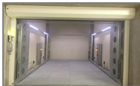
Plateforme au niveau inférieur en position accès au garage
